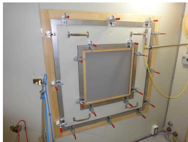
▲写真 2 設置した試験体(音響透過損失)
