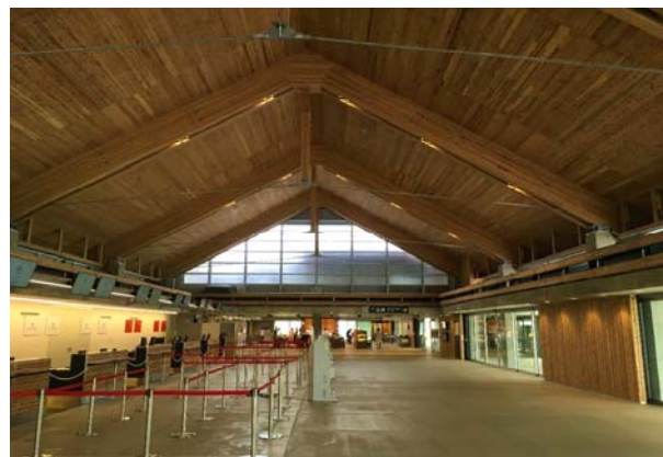
同技術が採用された空港ターミナル屋根(CLT屋根)
