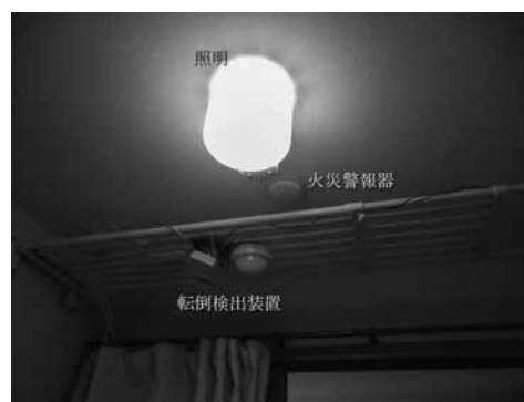
写真5 グループホームのトイレに設置したセンサ（照明のセンサや火災警報器に干渉しない位置に設置する）
