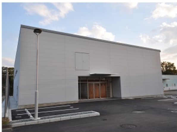
図 1 車載機器用 EMC 試験施設の外観
