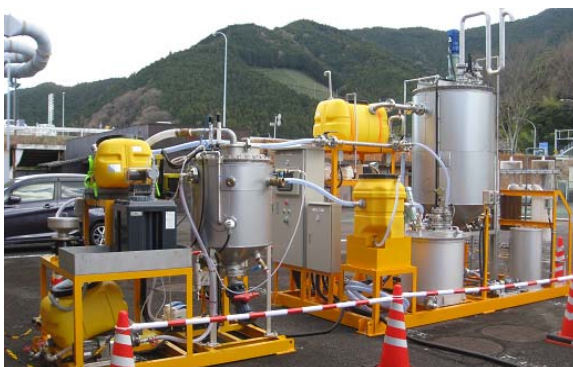
図1 メタン発酵パイロットプラント
