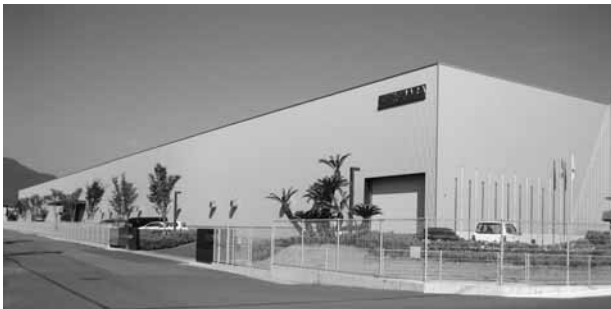
写真2 完全密閉工場（篠原鉄工所）
