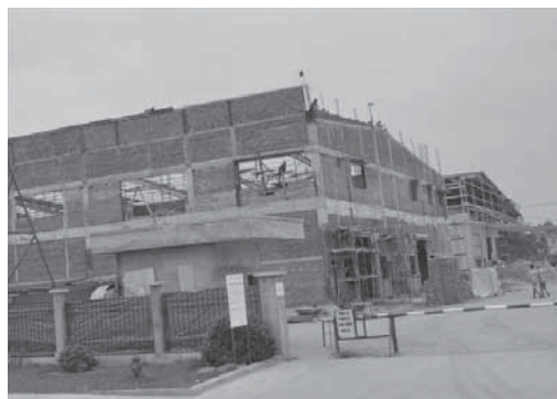
写真1 建設中の工場
