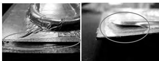
図5 環境試験後のパネル裏面の剥がれ
