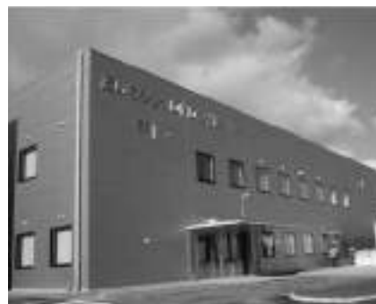
写真1 あいちシンクロtron光センター(愛知県瀬戸市) 公益財団法人科学技術交流財団が運営管理を行っている。
