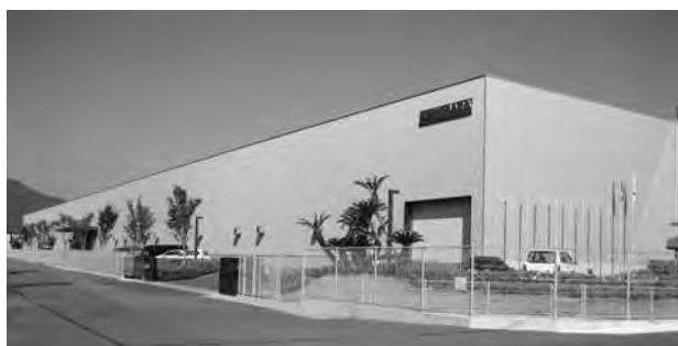
写真2 完全密閉工場（篠原鉄工所）
