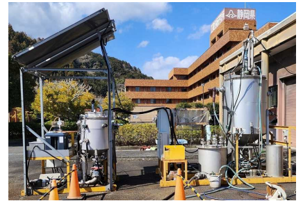
メタン発酵パイロットプラント
